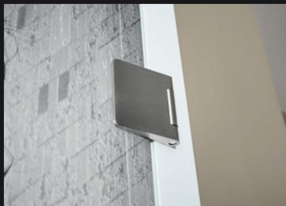
Detail: Ultraflaches Glastürband
