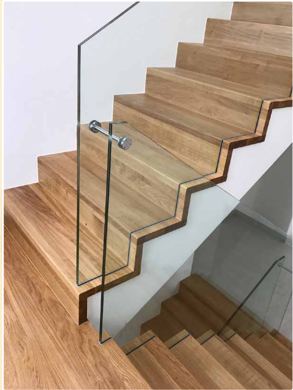
eingenutetes Glasgeländer mit Edelstahlverbinder
