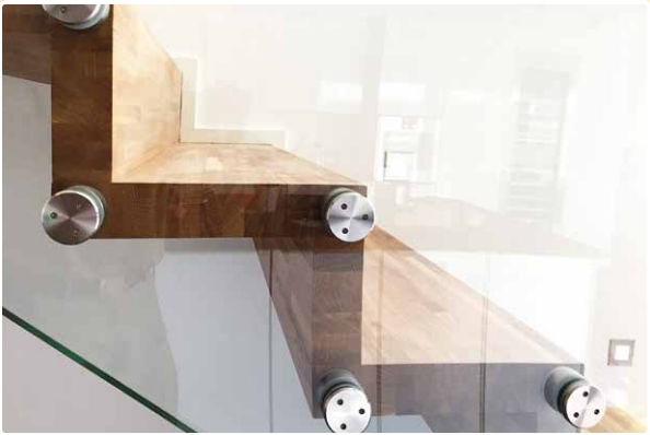
▲ Detailansicht Edelstahl-Glaspunkthalter
