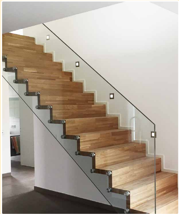
▲ Glasgeländer mit Edelstahl-Glaspunkthaltern
